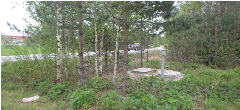
Kuva: Näkymä Kylmäpurontien varressa, kiinteistöllä 178-439-1-107 "Voimala", sijaitsevasta kunnallisteknisestä kaivosta (kuva: Arkko. 25.5.2021).
